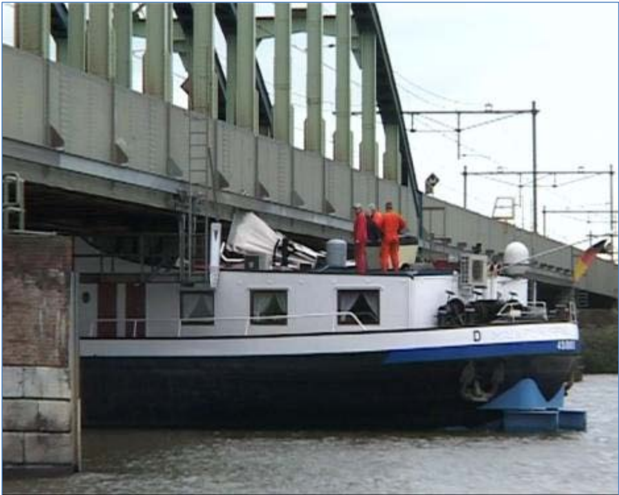
Abbildung 34 Schaden nach einer Kollision auf der Elbe (Deutschland)
