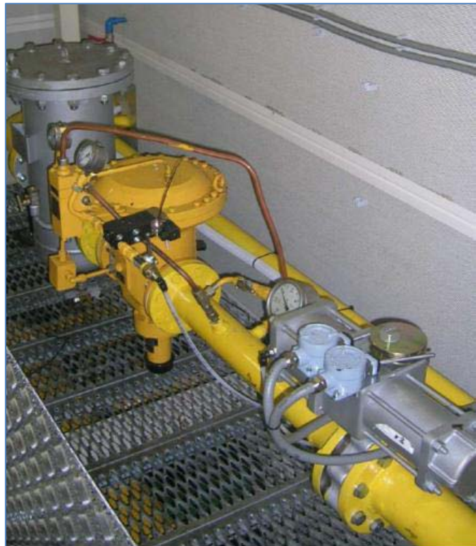
Abbildung 15: Offene GVU. Quelle: Wärtsilä
