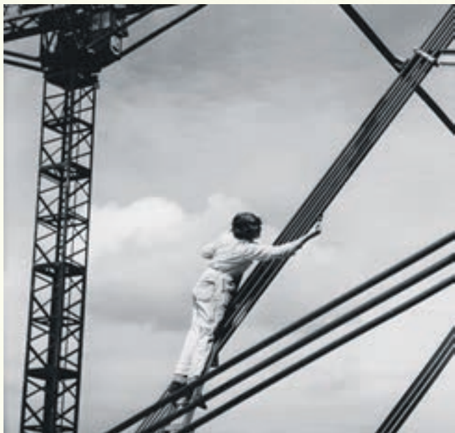
Bouw vrachtgebouw Schiphol, bouwbedrijf IBC (ca. 1966)
