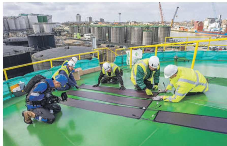
Solar powerfoil op een tankdak van Vopak.
